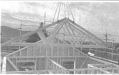
トラスを3～4本接合した「PUT（ブット）」（Prime Unit Truss）工法で製作
