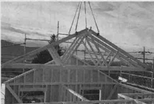
「ユニットトラス」の施工現場の様子(上)トラスを固定してユニット化したもの
